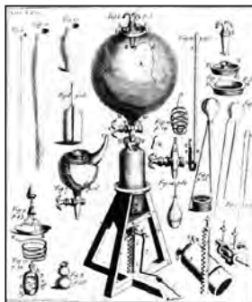
Dibuixos d'instruments dissenyats per Robert Boyle i el seu ajudant, Robert Hooke. L'aparell central, més voluminós, és la primera bomba d'aire.
